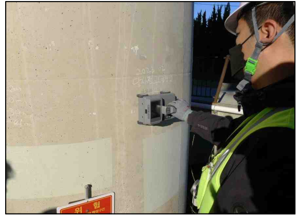
d. 철근탐사 측정
